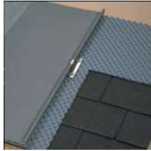
Uygun olmayan alt yapı üzerine delta VMZINC çatı uygulama örneği
