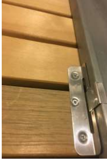
Hareketli klipsler ahşap alt yapıdan bağımsız çalışır.
