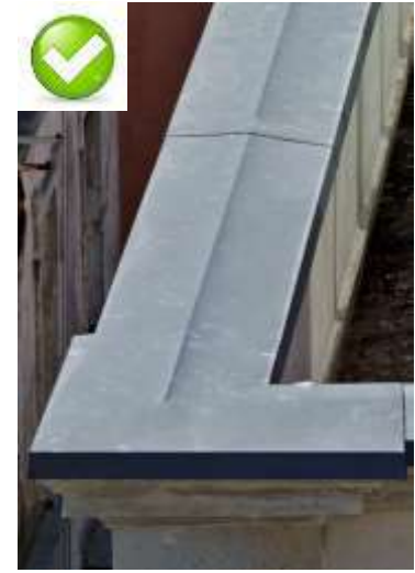
Geniş harpuştada çift yöne eğim verilerek eğim prensibine %100 uyulmuştur.
