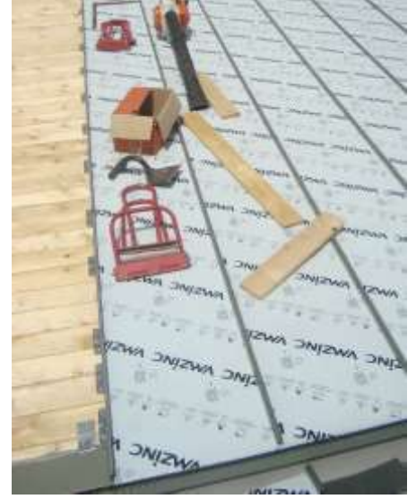
Hareketli klipsler saçak ucunda daha sık kullanılmalıdır.
